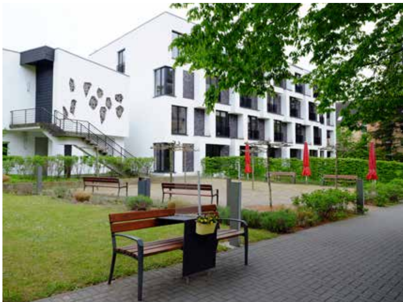
Corona-freundliche Bank vor dem Neubau des Edmund-Hilvert-Hauses
